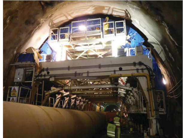
Obr.14 Osádzanie debnenia hornej klenby
