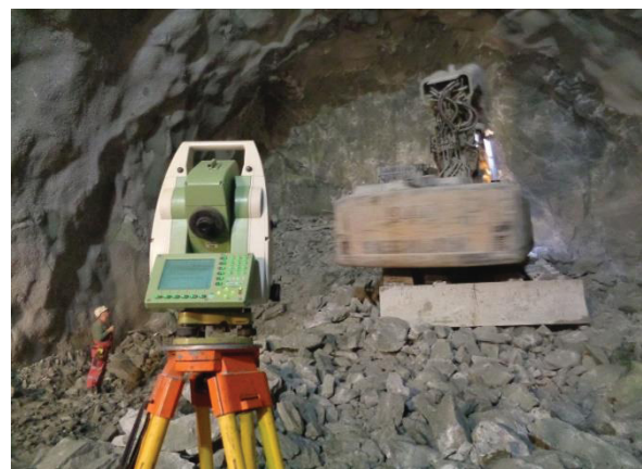
Obr. 8 Kontrola vyrazeného záberu
