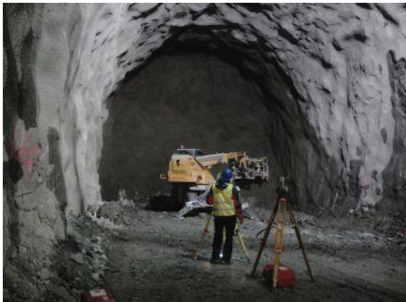
Obr. 7 Vytýčovanie razeného profilu
