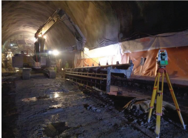
Obr. 13 Osádzanie debnenia zákl. pásu
